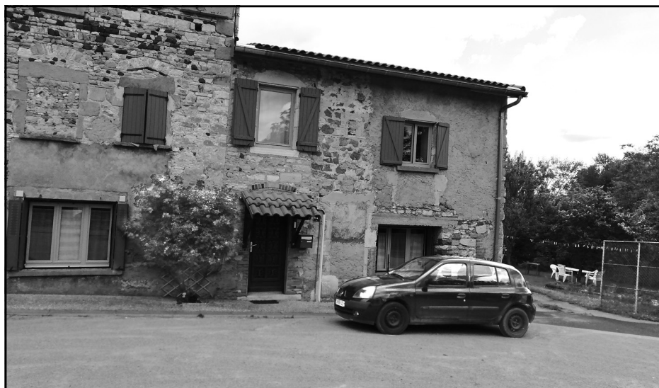
La maison de Chas.
