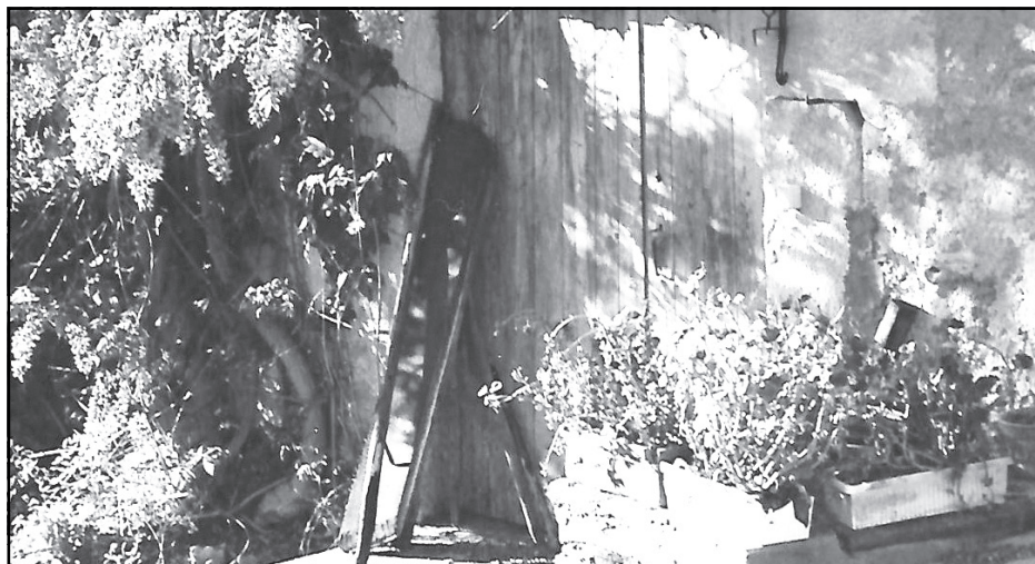
Entrée du cuvage et de la cave aux Cohériers.
